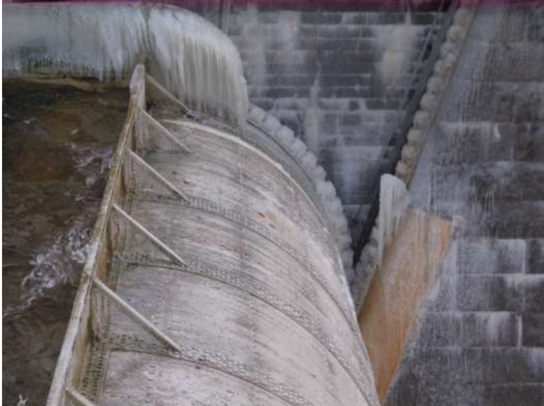
Kuva 6. Valssiluukun hammasrattaiden jäätyminen [Laasonen & Isomäki, 2018].
