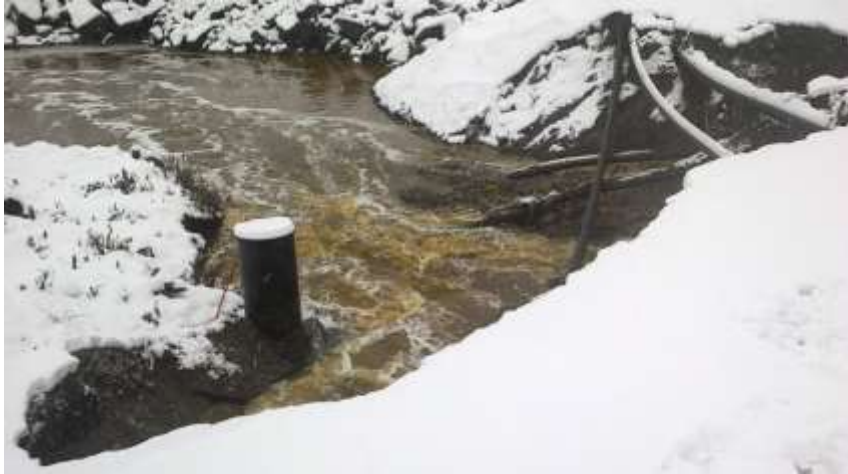
Kuva 13. Ensimmäinen havaittu vuotokohta.
