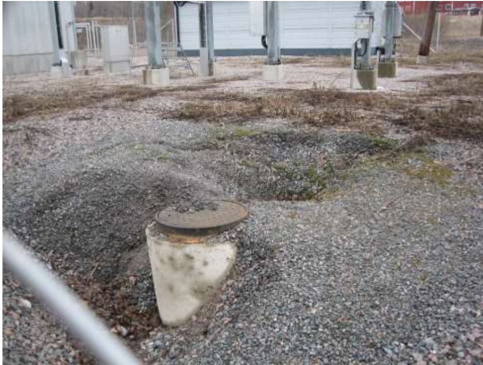
Kuva 9. Kytkinkentän vajoama, 21.3.2007 [Laasonen, 2010].
